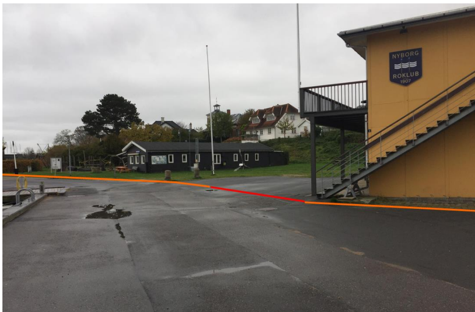
Figur 6-3 Placering af sikring på strækning B-C (orange) og strækning C-D (rød) samt starten på strækning D-E (orange)
