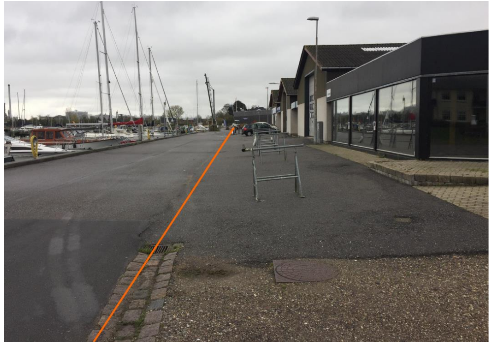
Figur 6-5 Placering af sikring på strækning F-G
