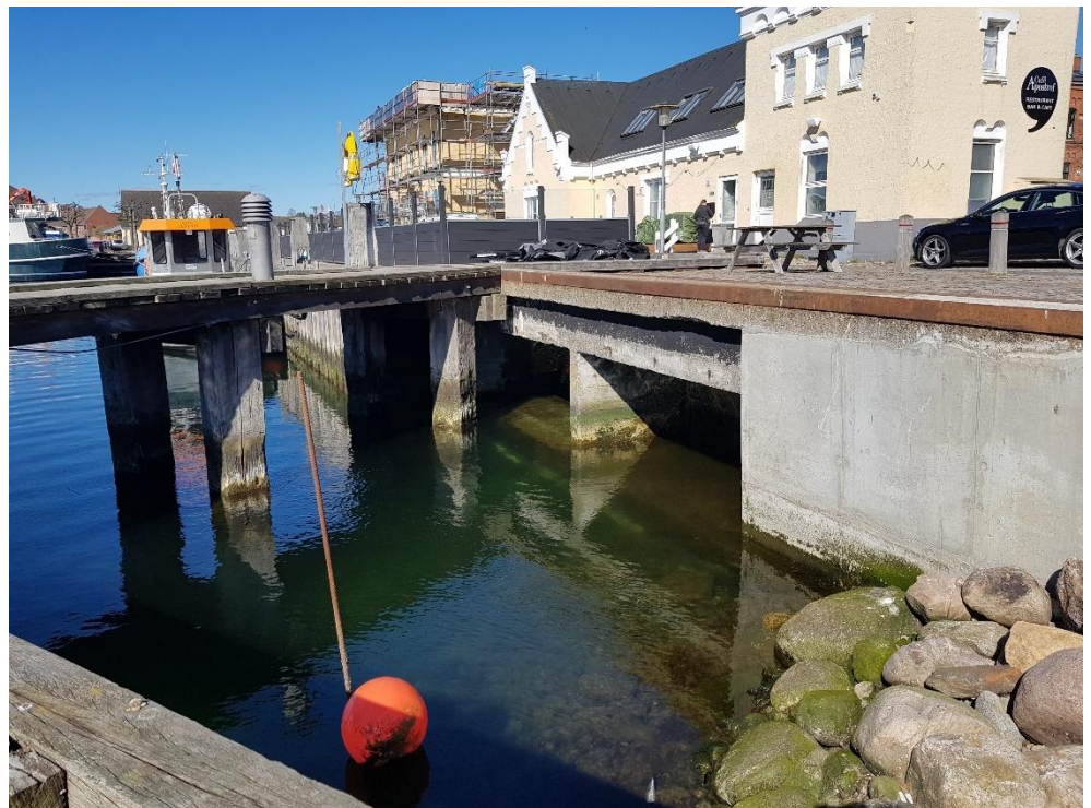
Figur 3-3 Voldgravens udløb i havnebassinet (til højre). I bygværket under Havnegade findes i dag en passiv højvandsklap.
