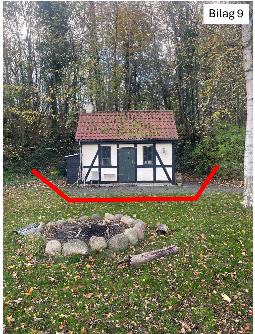
Omkring udhus laves der et dige der følger overgangen mellem fliser og græs. Dige slutes og starter i den høje bakke bag huset.
