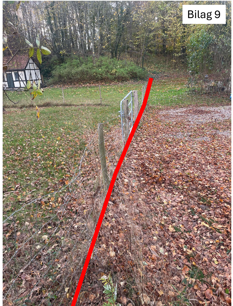
Diget følger overgangen mellem gårdsplads og græsplæne og sluttet af i bakken på modsatte side. Denne placering af diget, tæt på huset, er lavet da diget her kan være lavest muligt samt mest mulig beskytte for evt. "bølger"
